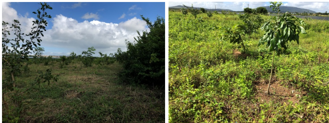
Açude da Marcela /Itabaiana: Fiscalização das atividades de manutenção
